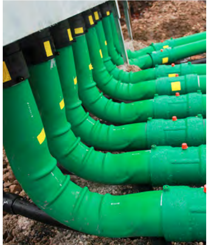
KPS bends below fill point
